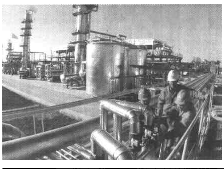
10月8日，技术人员在长庆油田公司采气一厂第一净化厂检查新建投产的日处理400万立方米天然气净化装置的管道接口。中国石油长庆油田公司采气一厂第一净化厂是在陕西榆林靖边毛乌素沙漠上建成的中国最大的现代化天然气净化厂。
